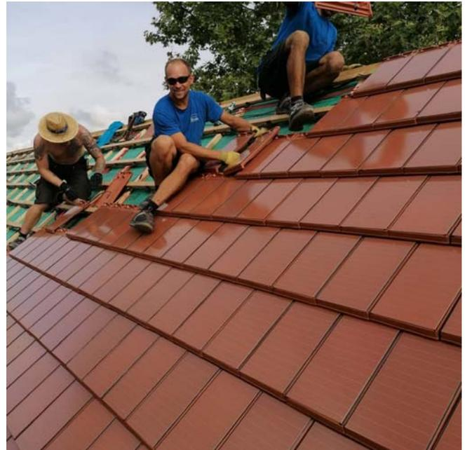
geln belegen (siehe Abbildung). Zugeschnittene Ziegel aus dem Basismaterial füllten schmale Ecken und Seiten des Daches, für welche der Solardachziegel zu groß gewesen wäre. Im Endergebnis lassen sich Ziegel mit und ohne Solarauflage kaum voneinander unterscheiden. □
